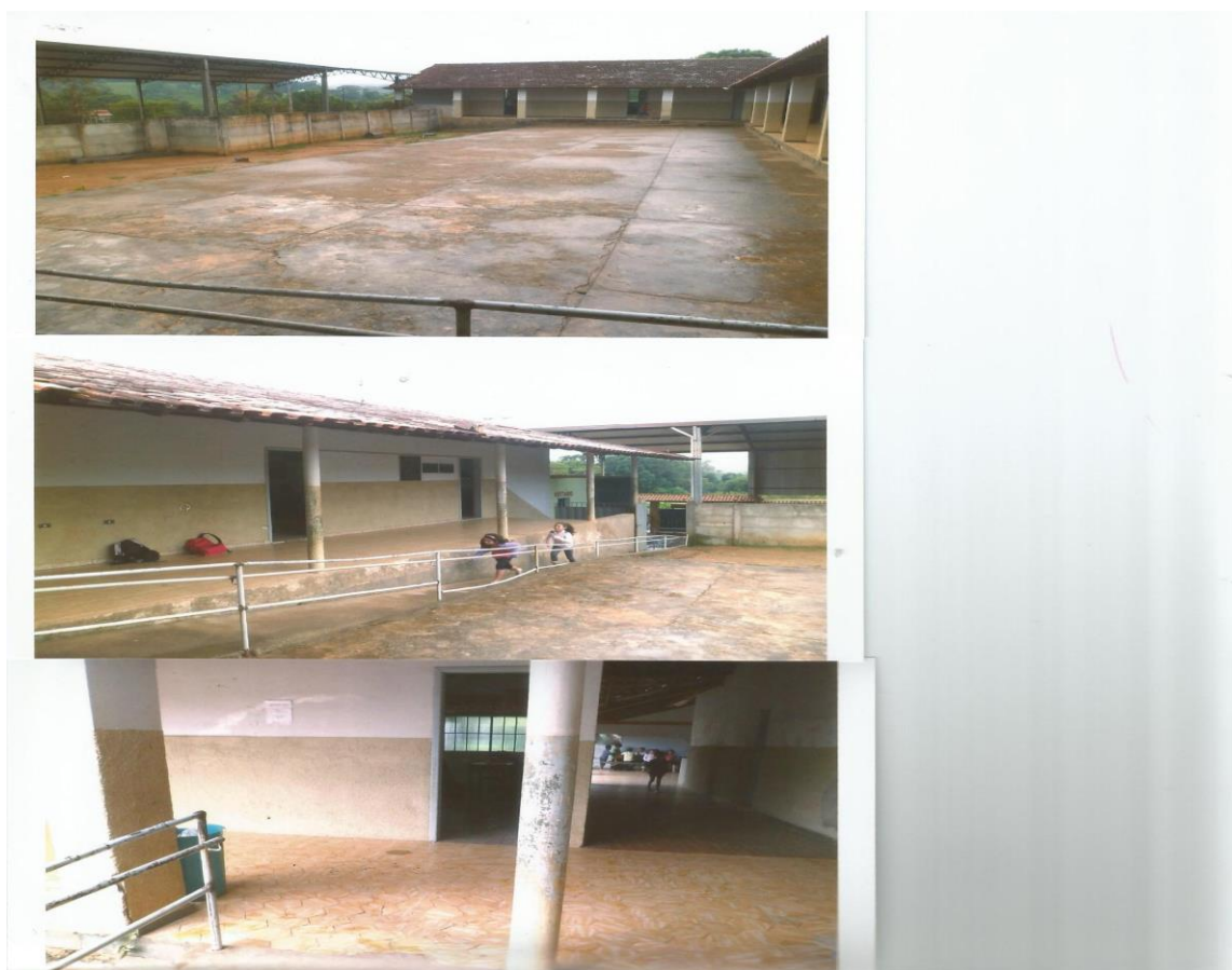
Figura 02- Espaço disponível para construção de salas e necessidade adaptação do espaço físico.
